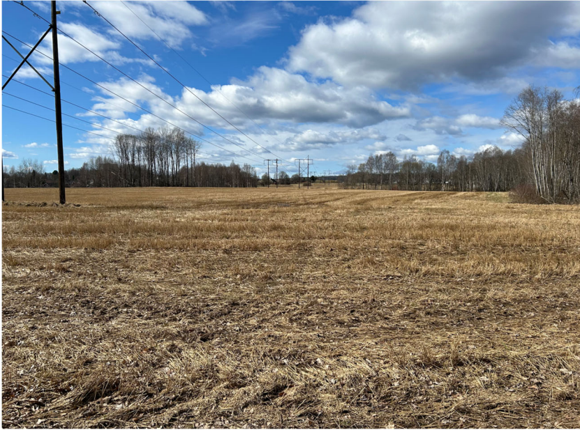
Figur 20. Fältet där markkabel övergår till luftledning
