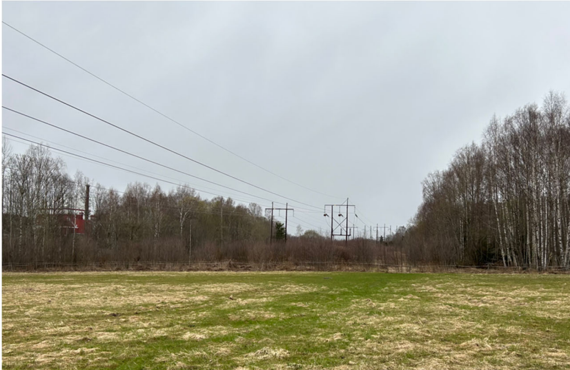
Figur 22. Sträckning i befintlig ledningsgata öster om Dalälven
